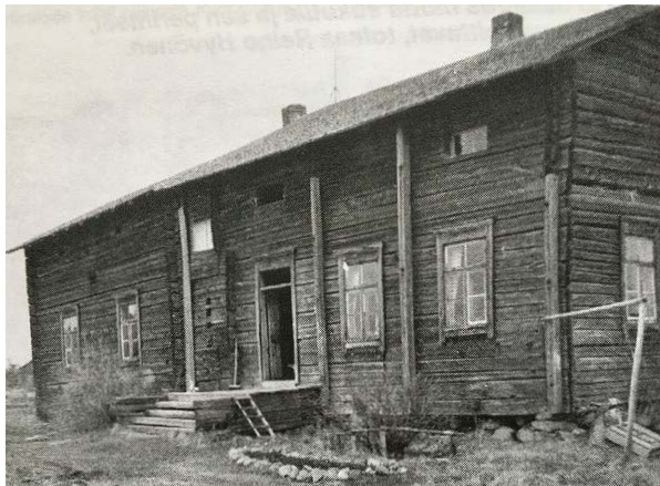
Pitkälän vanha päärakennus, joka on purettu noin vuonna 1965.
