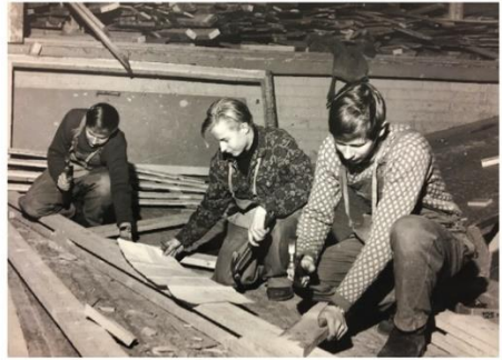
Ammattikoulun työsalissa syksyllä 1968. Naulattiin ristikkokattotuoleja. Piirustuksia opeteltiin lukemaan.
